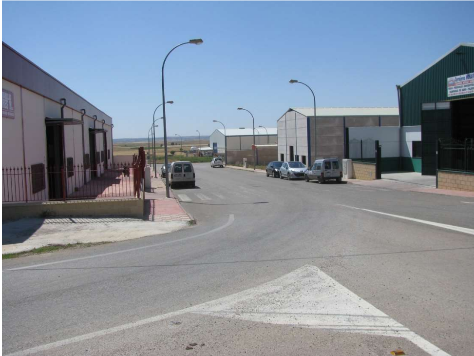
Calle "Los Gredales", acceso al Polígono desde la CM-310.
