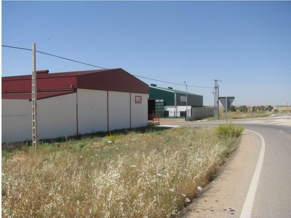
Acceso al Polígono industrial "San Sebastián" desde la carretera CM-310.
