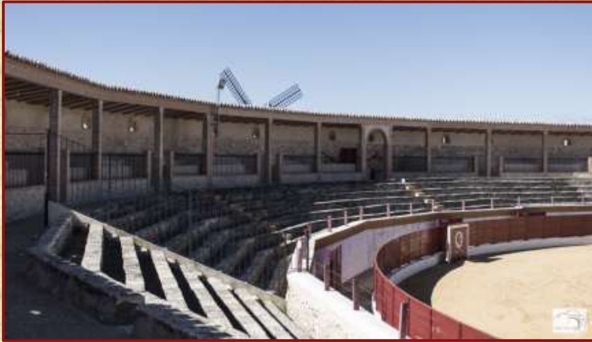
Vista tendido sombra y palcos
